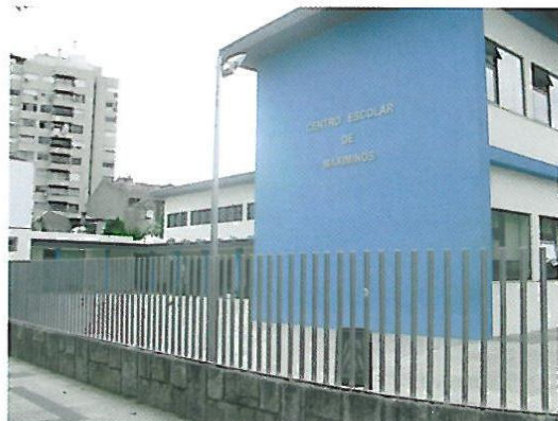
Renovado Centro Escolar de Maximinos
